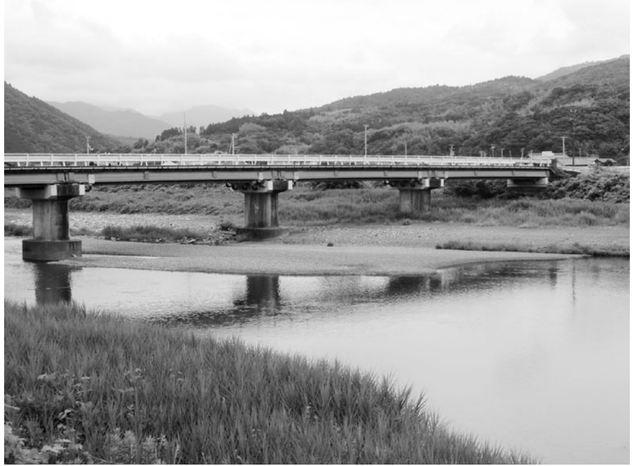
橋梁保全工事を行う東西島橋
