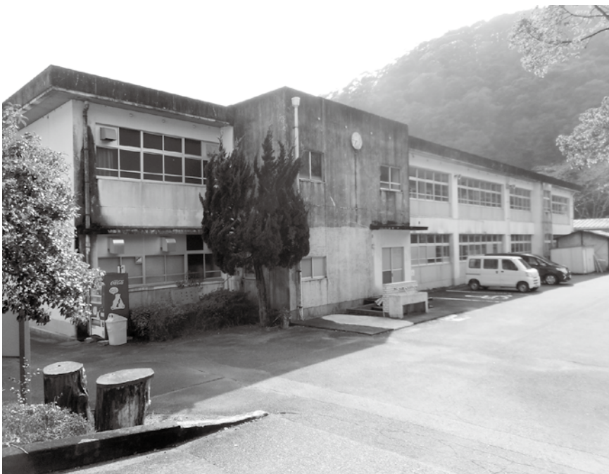
改修工事が計画されている旧中山中学校校舎
