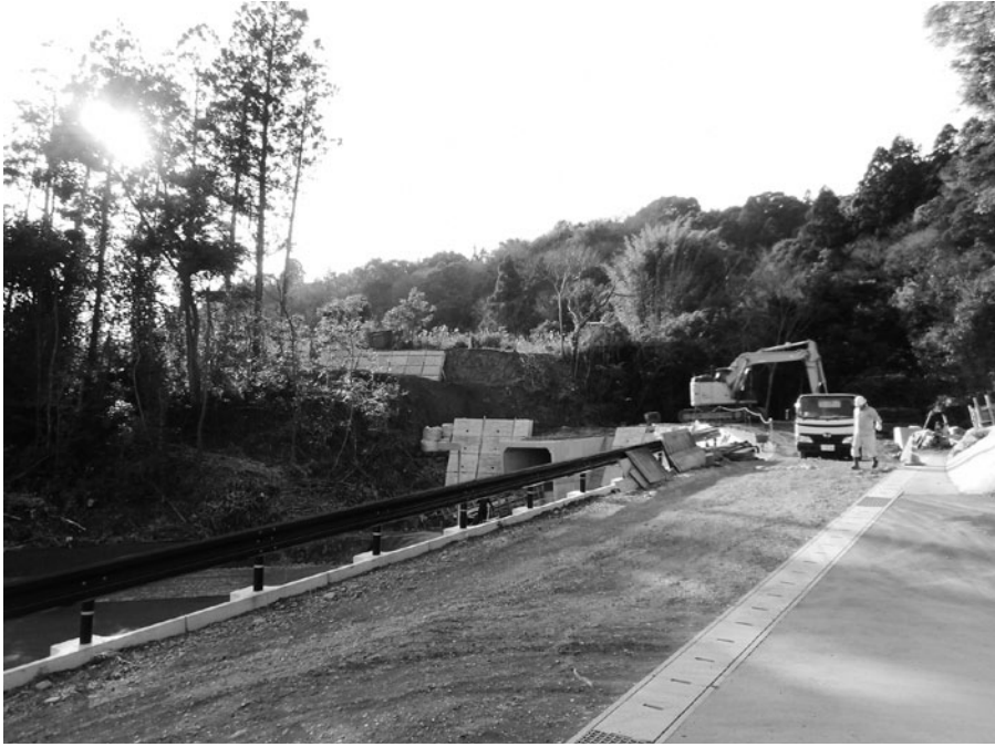
町道小野山線道路整備工事
