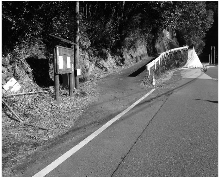
県道改修に伴い簡水工事予定の与床地区
