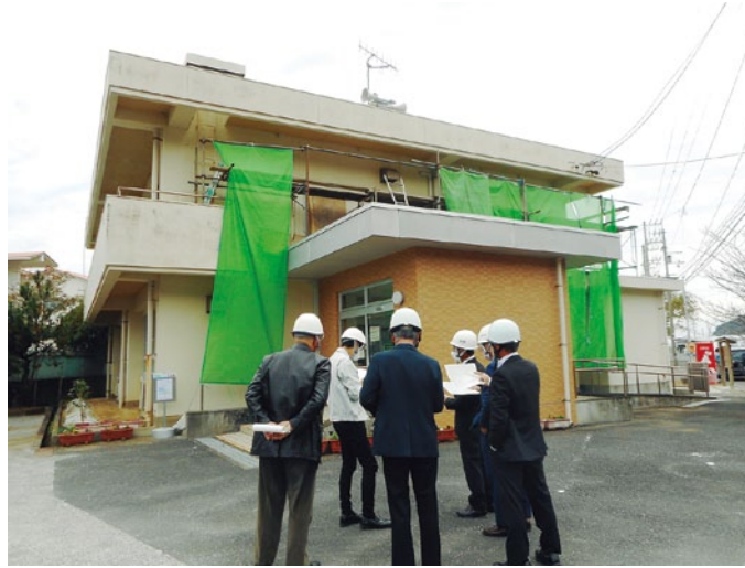
福祉館改修工事視察（産業厚生）
