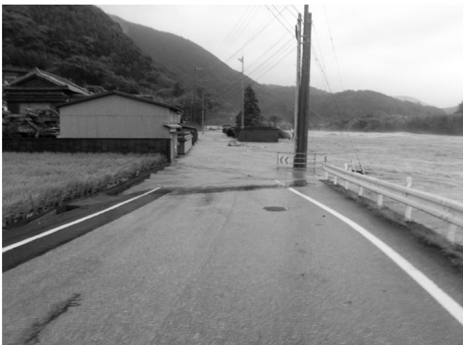
間下地区で安田川が氾濫（平成26年台風11号）
