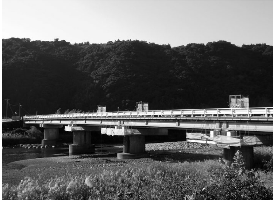
耐震改修中の東西島橋
