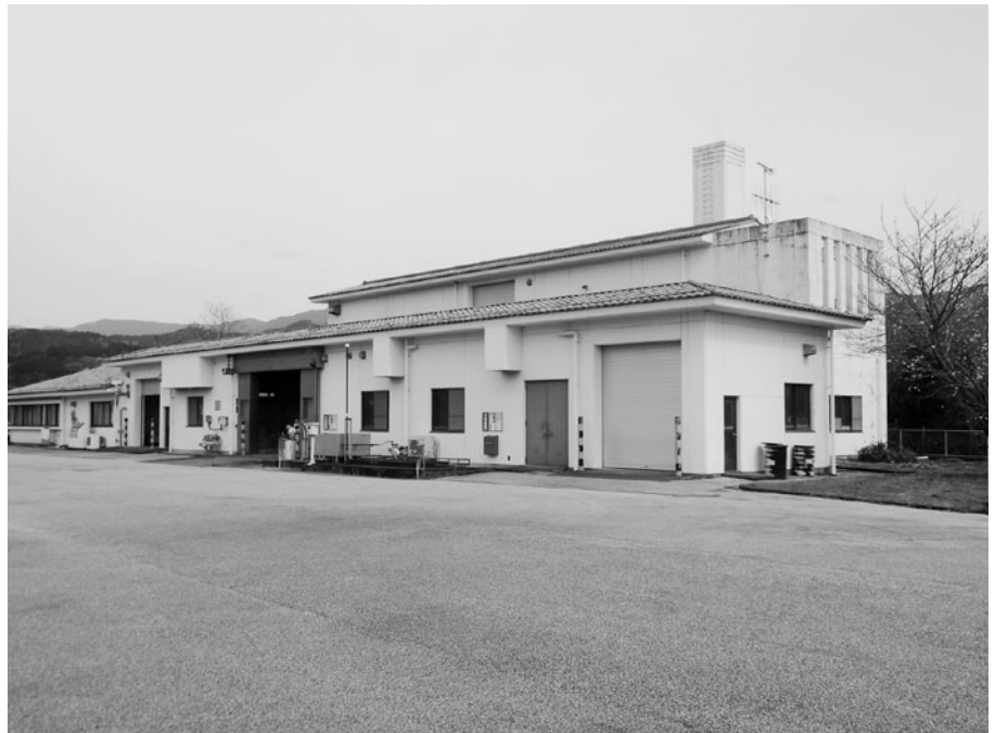
老朽化が進む「し尿処理施設」
