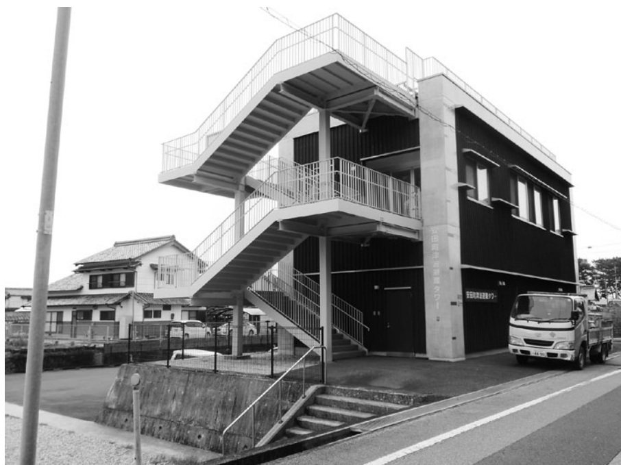
昇降機の設置が計画されている津波避難タワー1号
