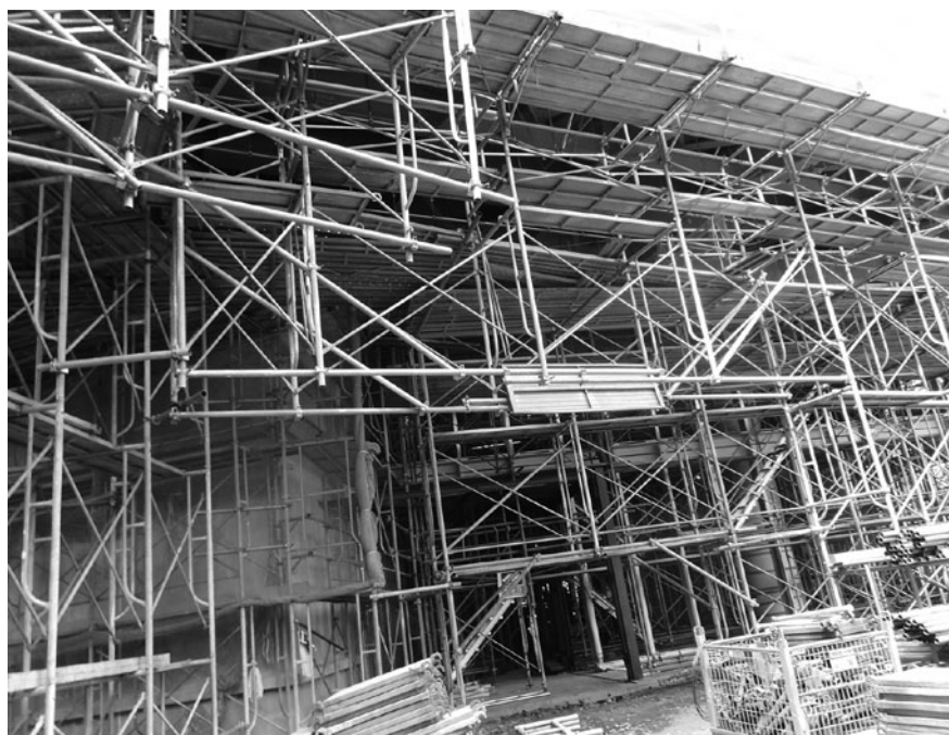
建設が進む新庁舎
