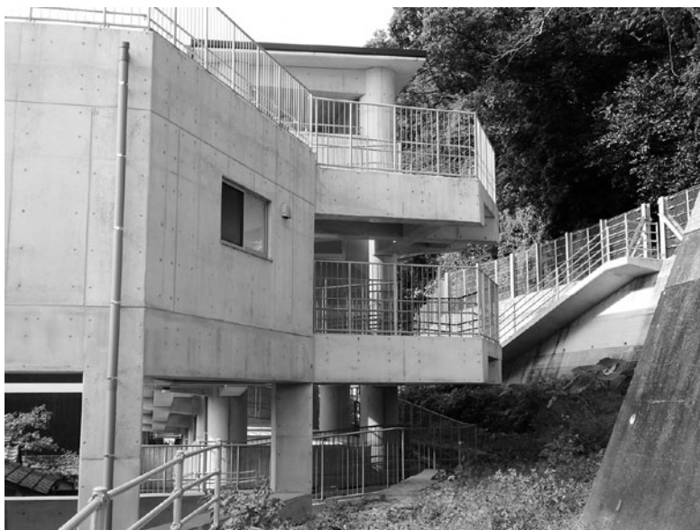
避難路から避難タワーへの架け橋
