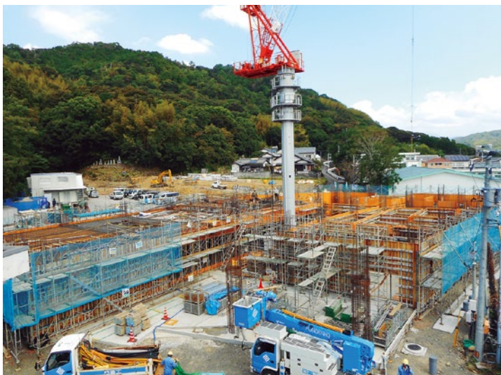
建設工事が進む新庁舎
