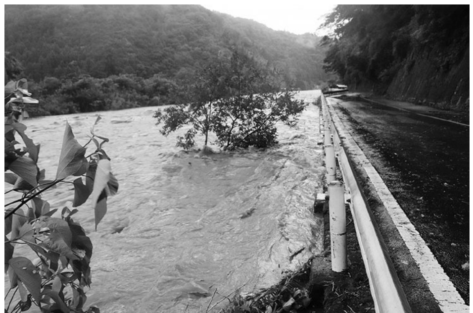
避難判断水位を超えた安田川（間下地区）
