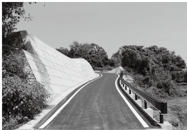
新設工事が完了した町道井ノ岡線
