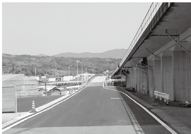
未改良区間の拡幅工事が完了した町道西ノ久保野田川線
