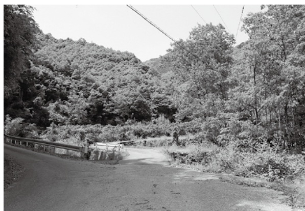
曲線改良が望まれる町道前久保線
