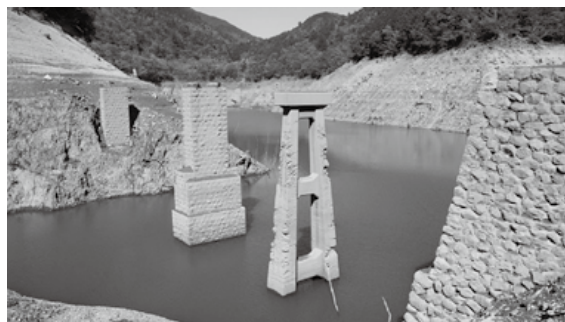
～湖底にそびえる橋脚跡～
