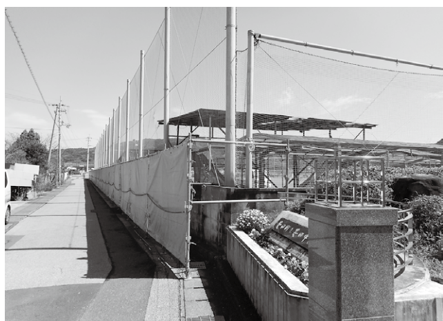
改修中のブロック塀
