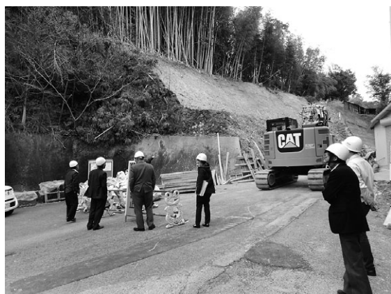
井ノ岡地区工事現場視察
