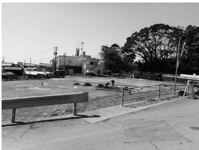
新庁舎建設地
