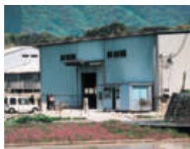
エコソフト(堆肥施設)
