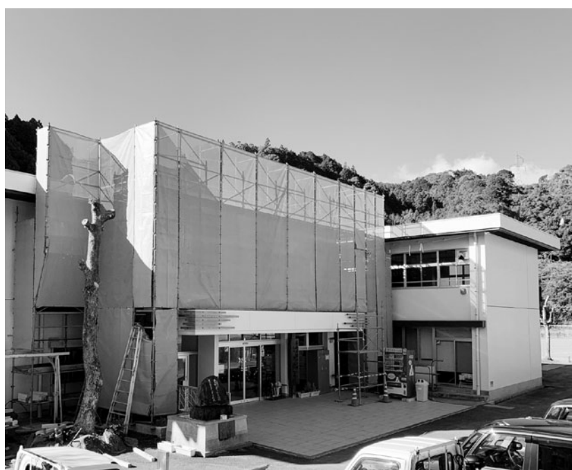
改修中の旧中山小中学校
