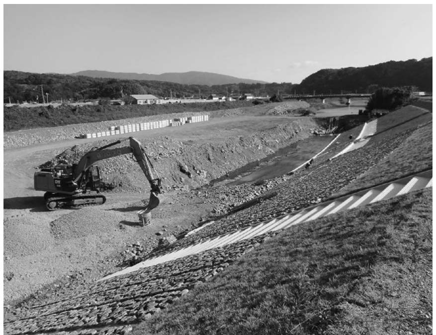
西島地区の護岸改修工事
