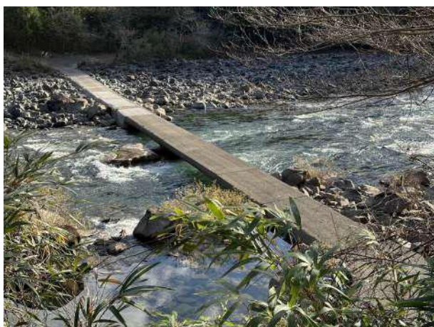
北川村未指定文化財 崎山沈下橋
