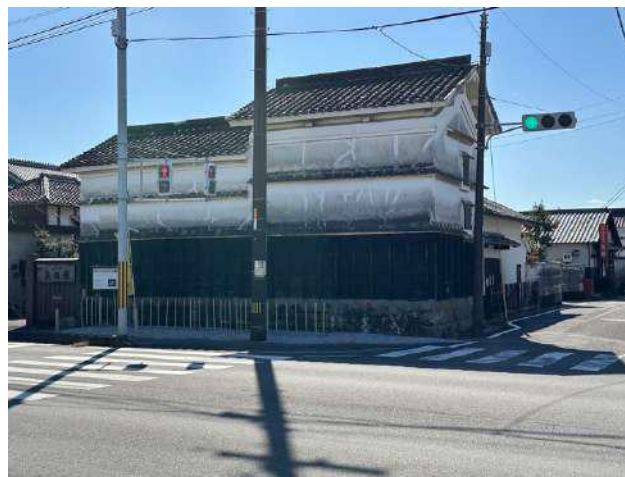
竹崎家住宅（国登録・有形文化財・建造物）
