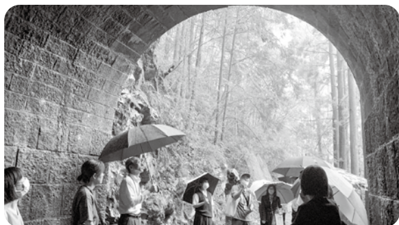
オオムカエ隧道
