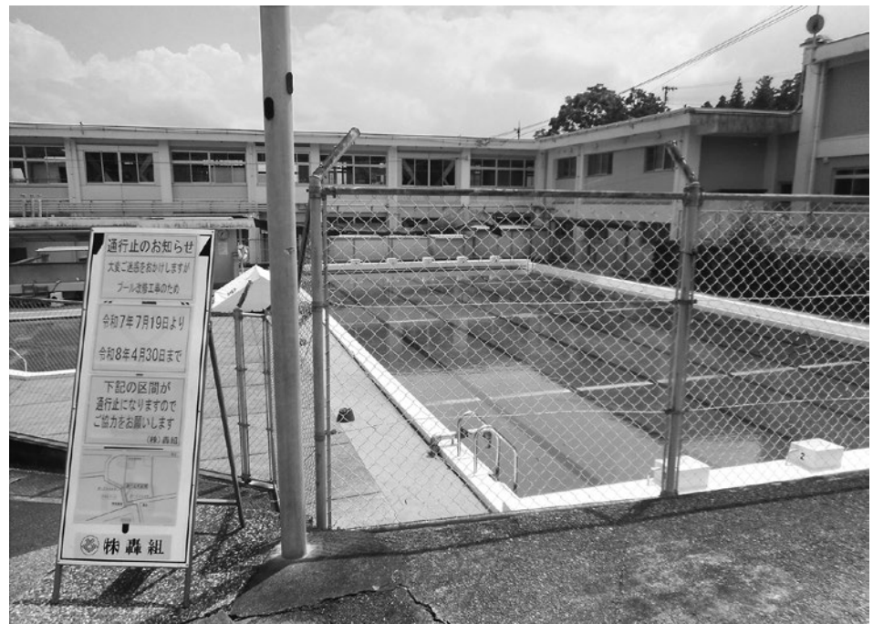
改築が始まる小学校プール
