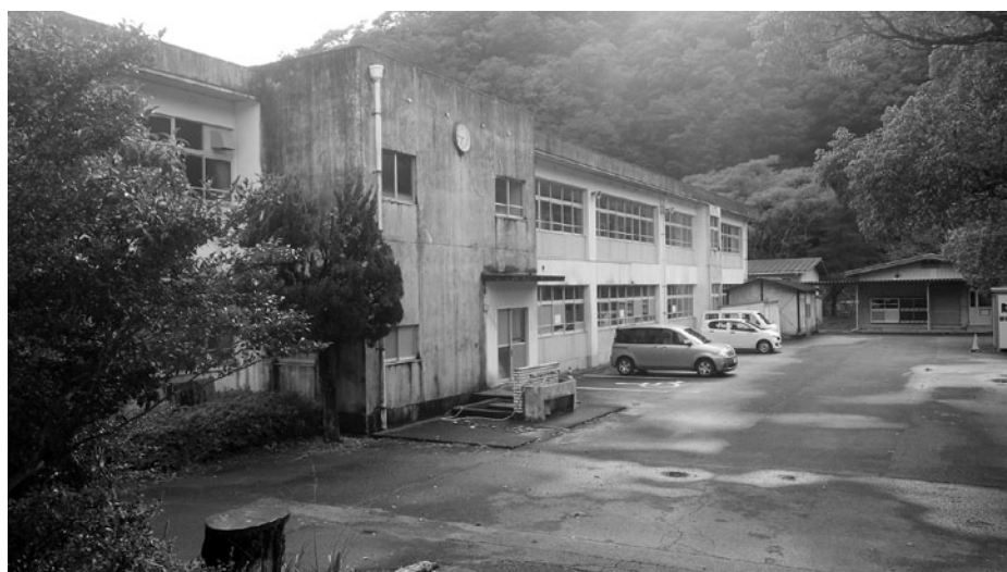
活用が検討される旧中山中学校校舎
