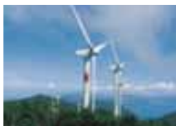
瀬戸ウィンドヒル発電所（愛媛県瀬戸町）
